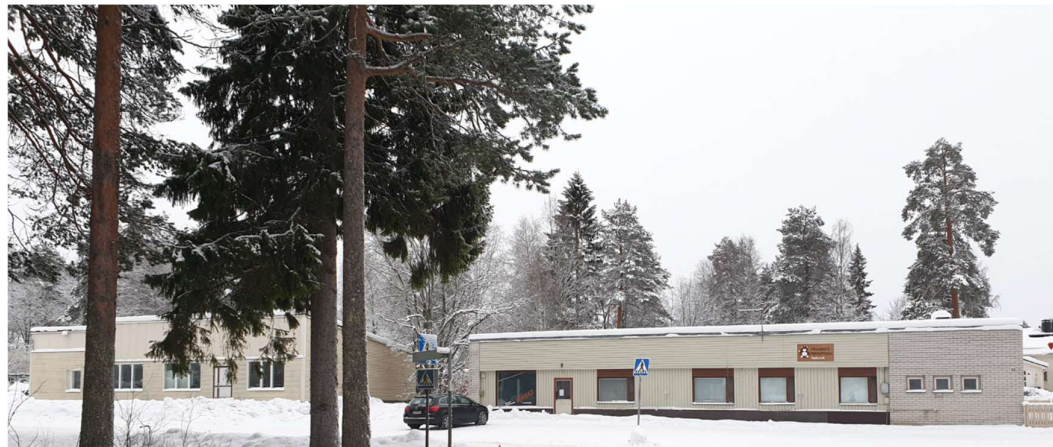
Kuvat 1-2, Liikerakennukset, joista oikealla sijainnut rakennus on purettu.
